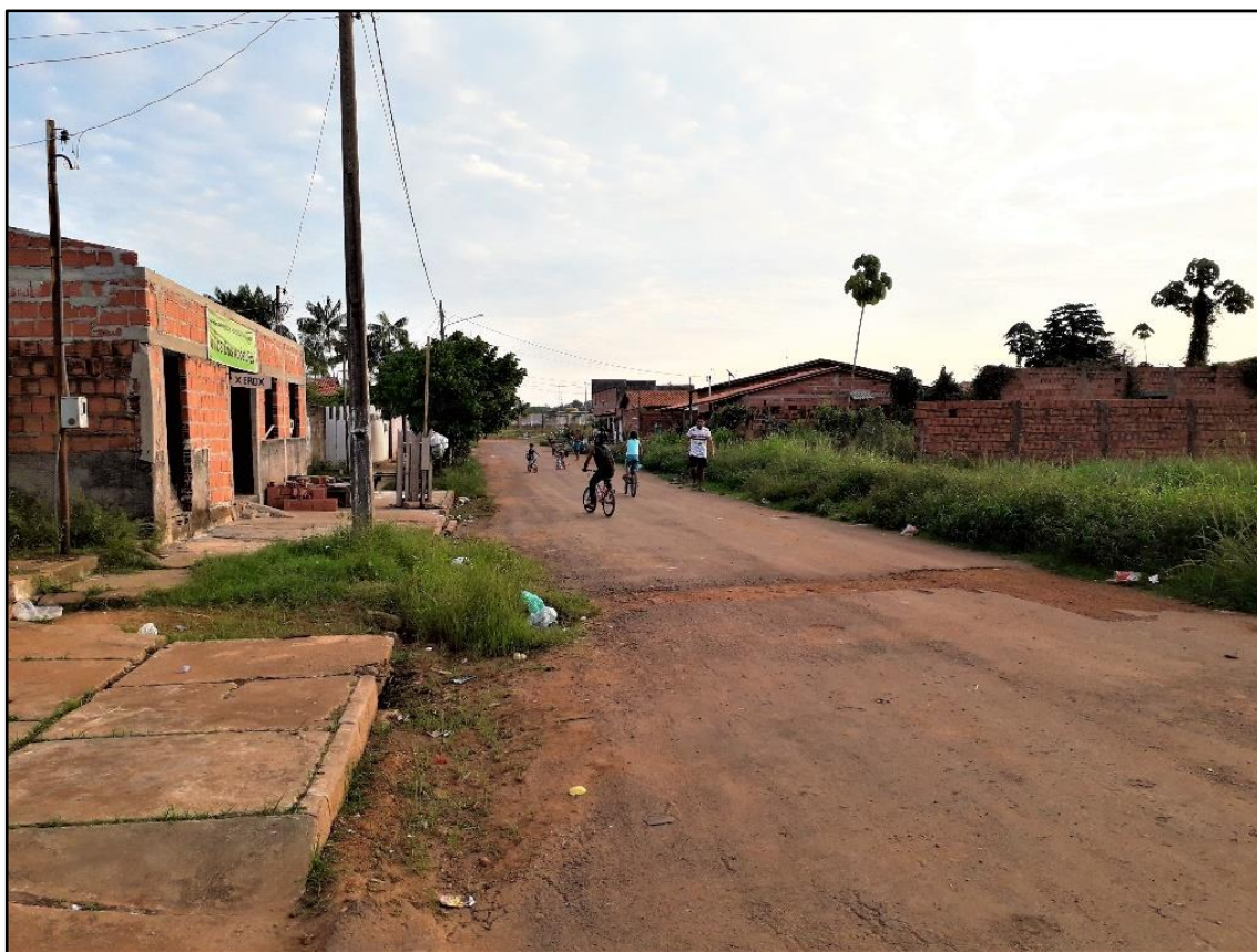
Foto 35 – Infraestrutura inacabada no bairro Nova Matinha: o bairro, que abrigaria a população desalojada em função da construção da eclusa, apresenta muitos problemas infraestruturais: asfaltamento inconcluso nas vias, precariedade de saneamento básico, incompletude de obras (posto de saúde, escolas, creches, centro de reabilitação) que produziram muitos espaços ociosos no local. Foto: Michel de Melo Lima (novembro de 2019).
