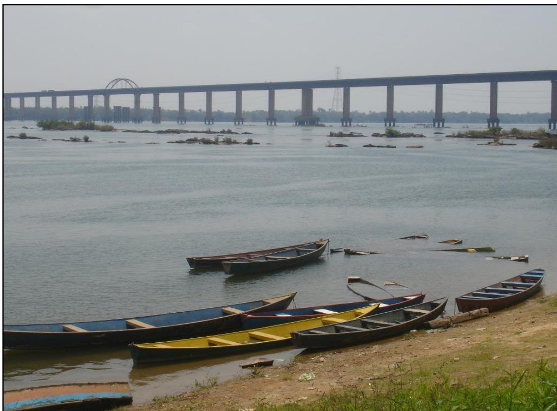
Foto 39 – Ponte mista rodoferroviária de Marabá: acima das diversas e coloridas canoas pode-se perceber a ponte de concreto e ferro sobre o rio Tocantins. Por cima da ponte passam, cotidianamente, diversos veículos automotores, além do trem de ferro de Carajás, que segue transportando minério em direção ao porto de Itaquí, no Maranhão. Por outro lado, por baixo dela, deslocam-se os diversos tipos de embarcações de pequeno e médio porte, que animam o espaço da orla da cidade. Foto: Saint-Clair Cordeiro da Trindade Júnior (setembro de 2010).
