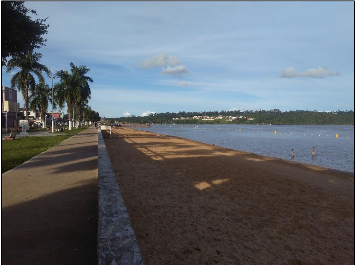
Foto 06 – Orla da cidade de Altamira no período recente: esse espaço, que foi habitado pela população de baixa renda e ribeirinha, sofreu grandes alterações após a construção da hidrelétrica de Belo Monte, dentre as quais destacam-se: a remoção da população original, as melhorias na estrutura da orla (calçadão e cais de arrimo) e da “praia”, e a instalação de diversos equipamentos de lazer (praças, quadras de esporte, academias ao ar livre). Foto: Michel de Melo Lima (fevereiro de 2018).
