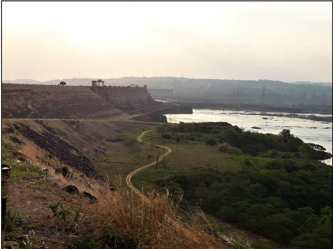
Foto 34 – Barragem do complexo hidrelétrico de Tucuruí: construção que seccionou o rio Tocantins, afastando-o de uma grande parte da população regional que historicamente fez de suas águas o seu principal referencial de identidade e de reprodução socioespacial comum. Foto: Michel de Melo Lima (novembro de 2019).
