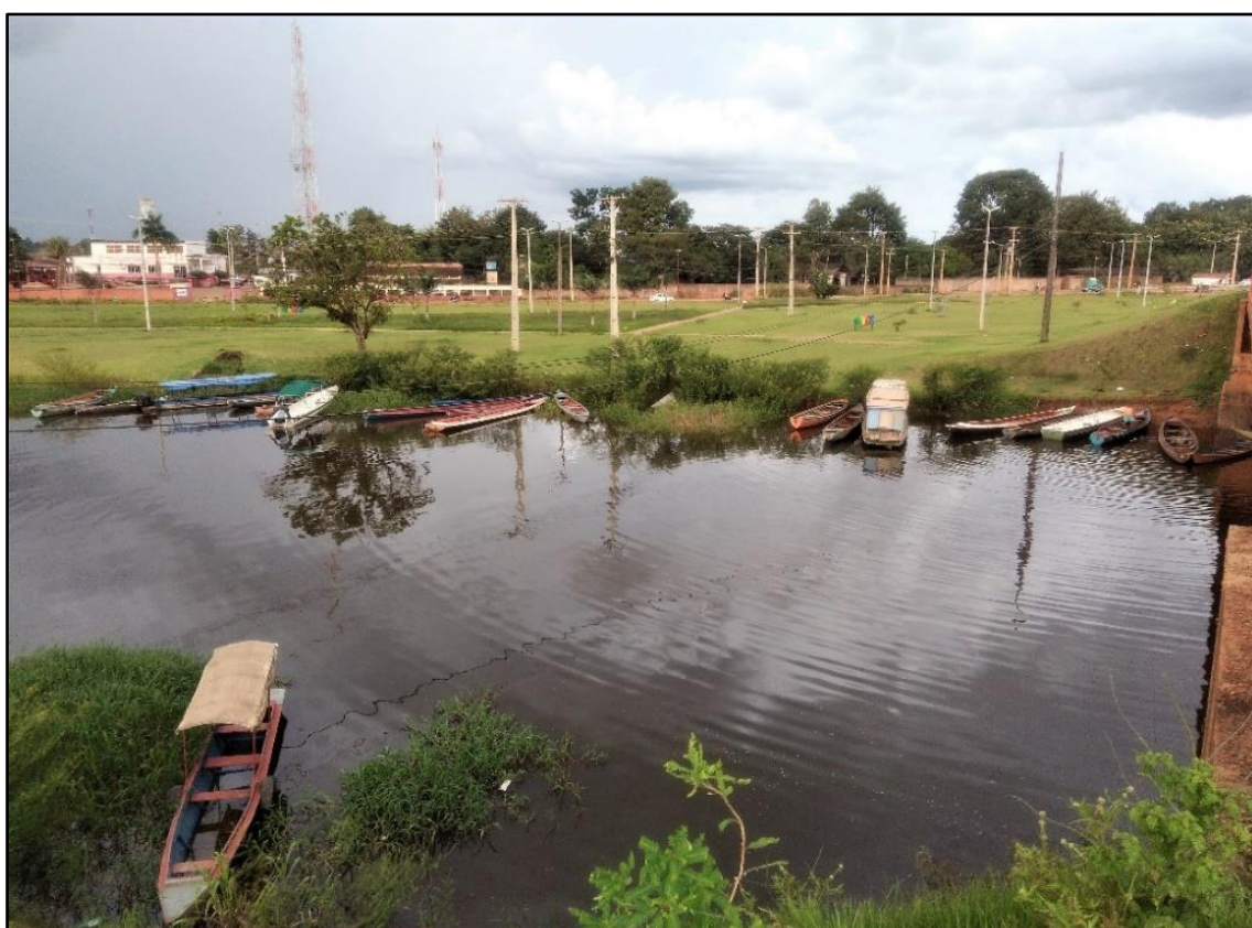
Foto 38 – Margens do Igarapé Altamira: de responsabilidade da Norte Energia S.A., este espaço, que anteriormente era formado por residências de pecadores, ribeirinhos, oleiros, indígenas etc., transformou-se em uma espécie “parque urbano” que se encontra subutilizado por conta da falta de finalização da infraestrutura paisagística (arborização, quiosques, passarelas, bancos, equipamentos de lazer). Foto: Michel de Melo Lima (junho de 2019).
